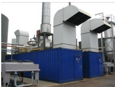
Kogenerační jednotky BPS Werlte
