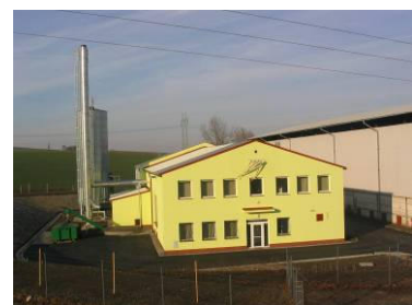
Bioenergetické centrum Roštín
