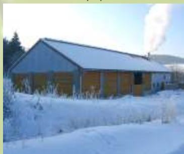
Obr. č.4 – Obecní výtahna Hostětín
