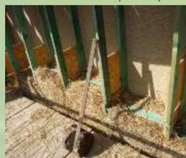
Obr. č.3 – Izolace slaměnými balíky
