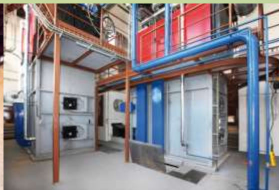
Obr. č.6 – Kotle na biomasu (odpadní dřevo, piliny, kůra)
