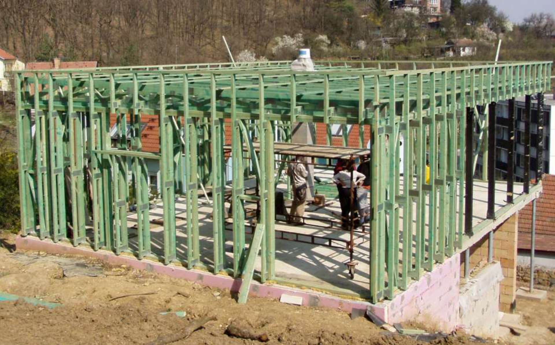
BRNO-JUNDROV RODINNÝ DŮM – DŘEVĚNÁ NOSNÁ KONSTRUKCE
