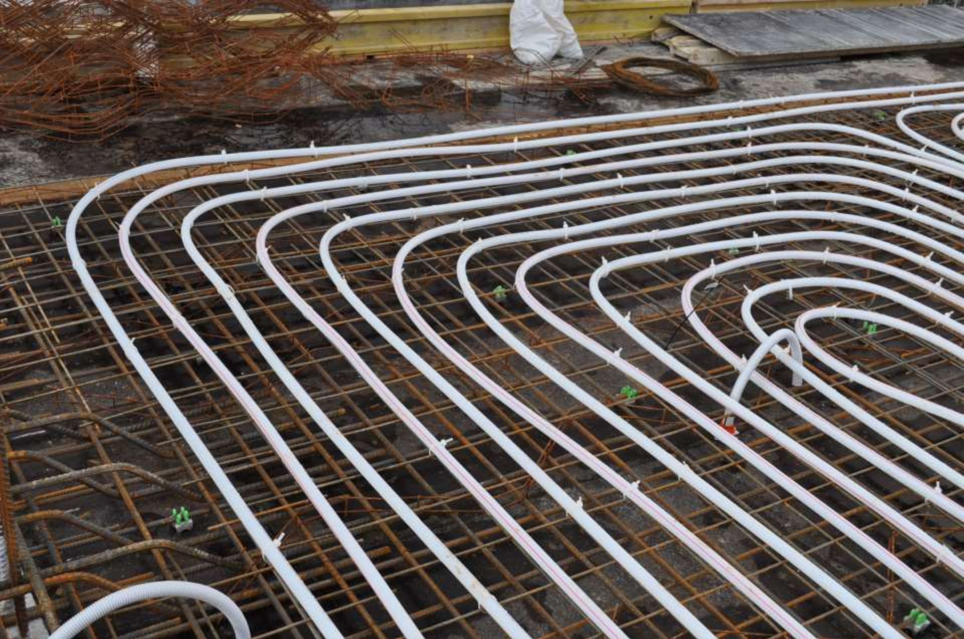
ROZLOŽENÍ HADIC NAD VÝZTUŽÍ AKTIVNÍ ŽELEZOBETONOVÉ DESKY
