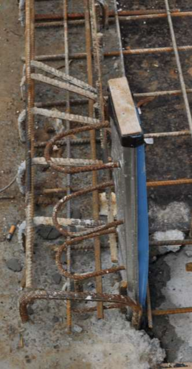
ŽELEZOBETONOVÁ STĚNA S „VYLAMO VÁKY“ A NAPOJENÍ NA SCHODIŠŤOVOU DESKU
