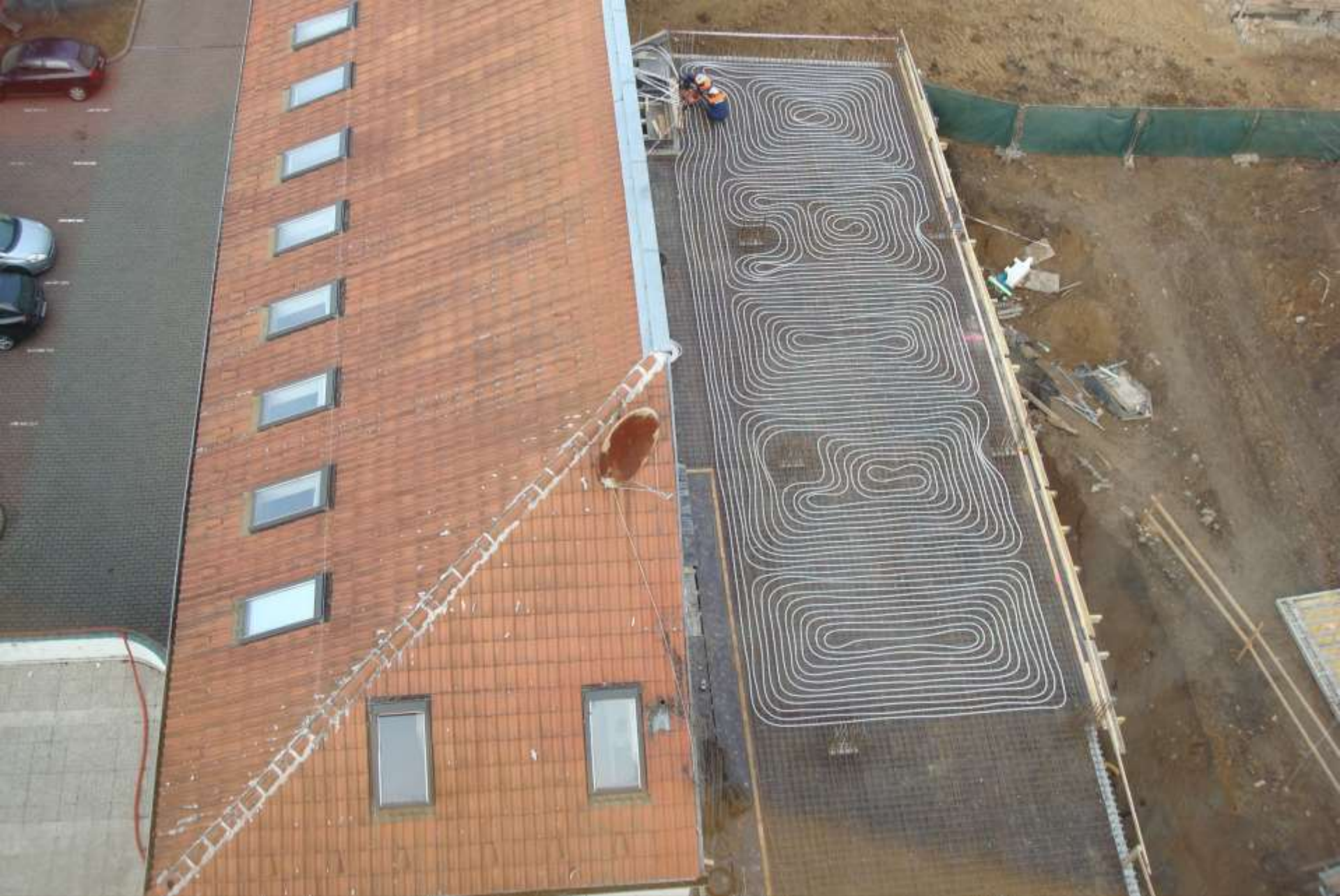
ROZLOŽENÍ HADIC NAD VÝZTUŽÍ AKTIVNÍ ŽELEZOBETONOVÉ DESKY
