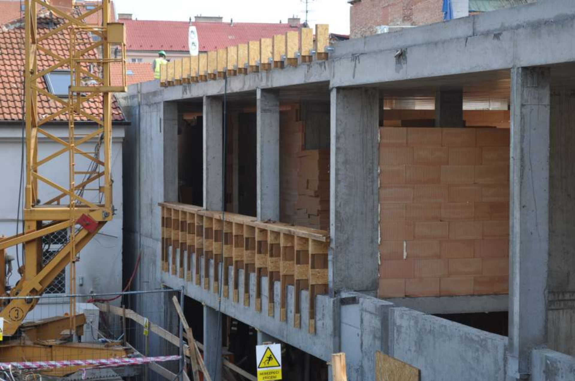
ATIKA A KONSTRUKCE OBVODOVÉHO PLÁŠTĚ
