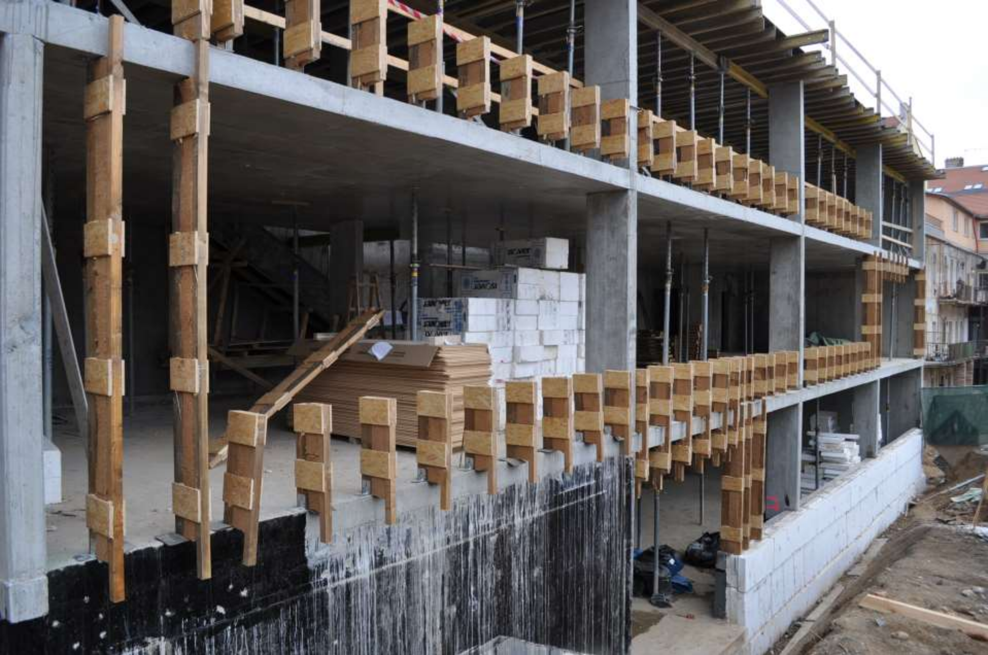
DŘEVĚNÁ VERTIKÁLNÍ NOSNÁ KONSTRUKCE OBVODOVÉHO PLÁŠTĚ
