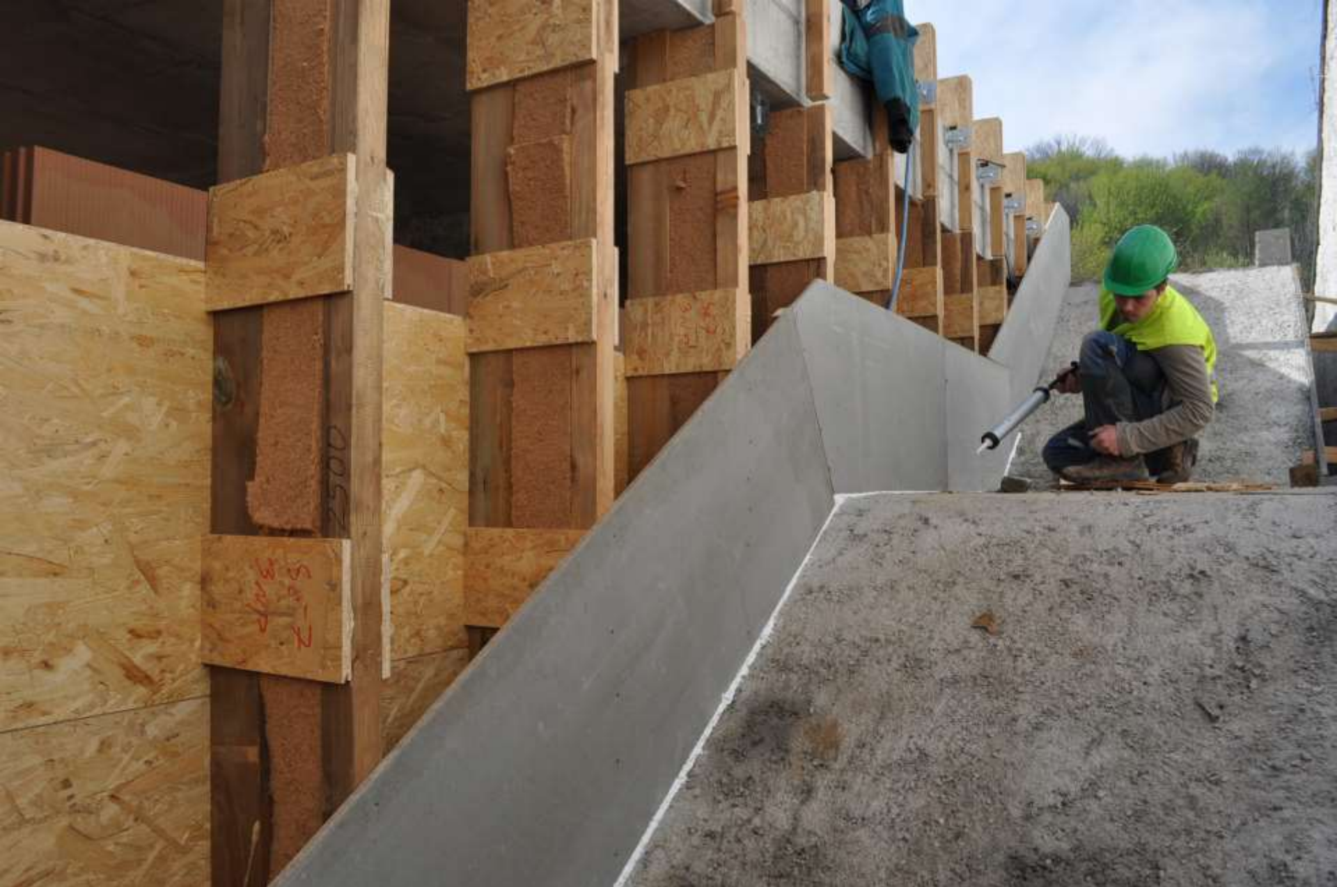
TĚSNĚNÍ STYKU VNĚJŠÍHO SCHODIŠTĚ OBVODOVÉ STĚNY
