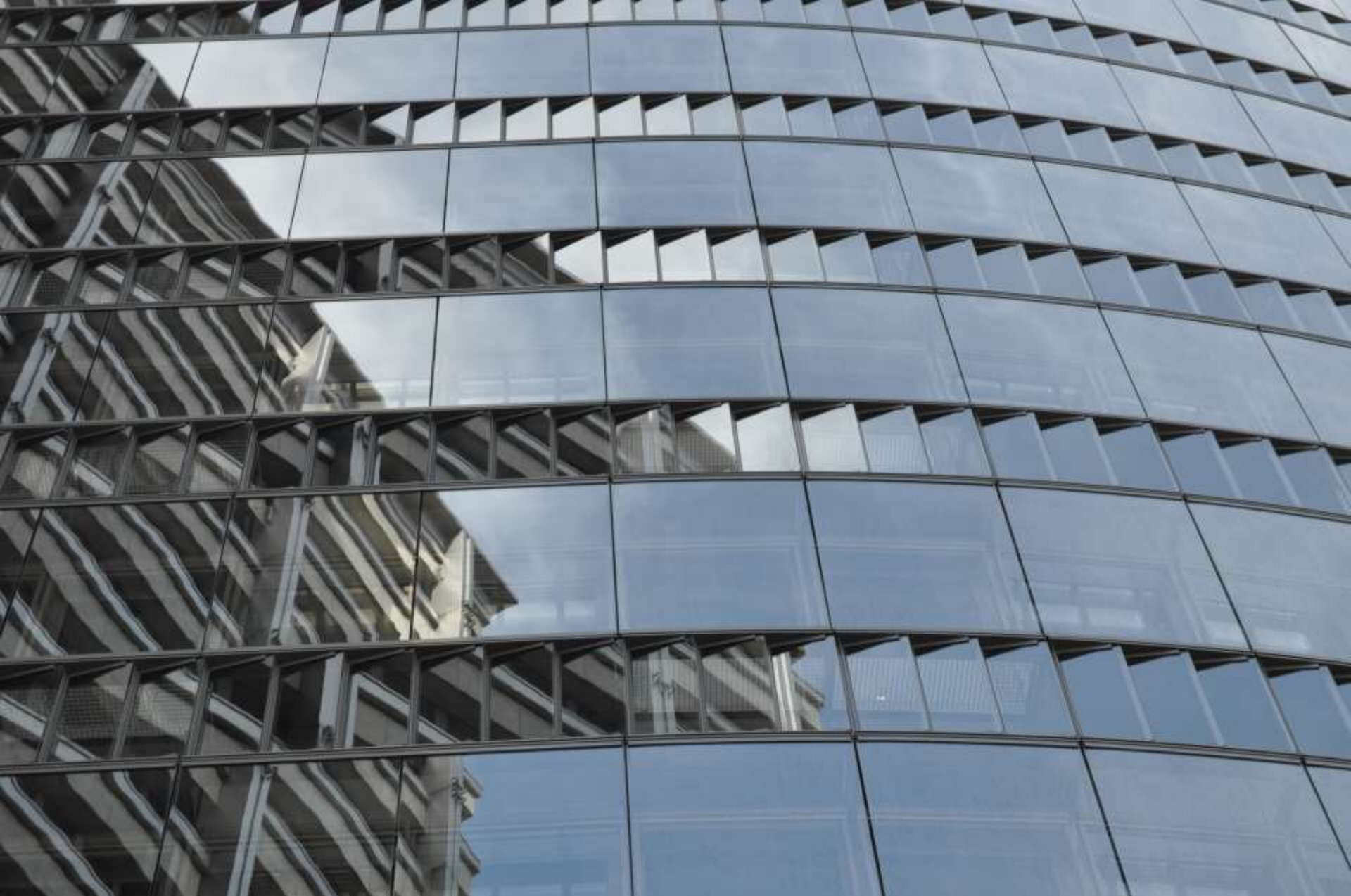
VÝŠKOVÁ BUDOVA RAIFEISENBANK ČLENĚNÍ PLÁŠTĚ VÝŠKOVÉ BUDOVY, KTERÉ UMOŽŇUJE JEJÍ VĚTRÁNÍ
