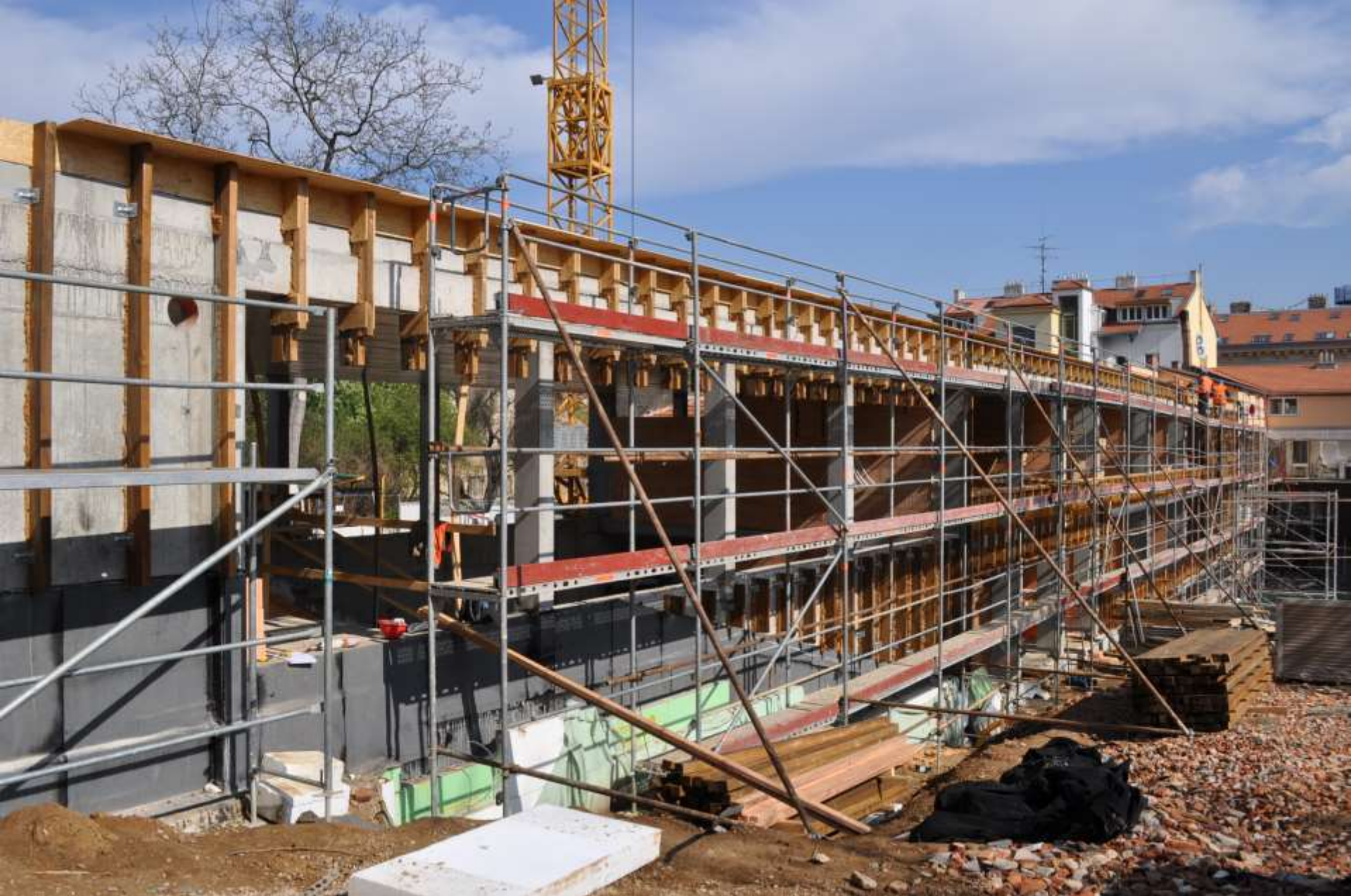
POKRAČUJÍCÍ MONTÁŽ DŘEVĚNÉ KONSTRUKCE OBVODOVÉHO PLÁŠTĚ
