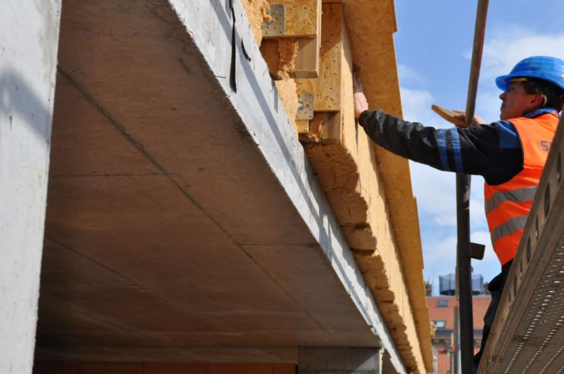
VKLÁDÁNÍ DŘEVOVLÁKNITÉ TEPELNÉ IZOLACE NA KONSTRUKCI ATIKY
