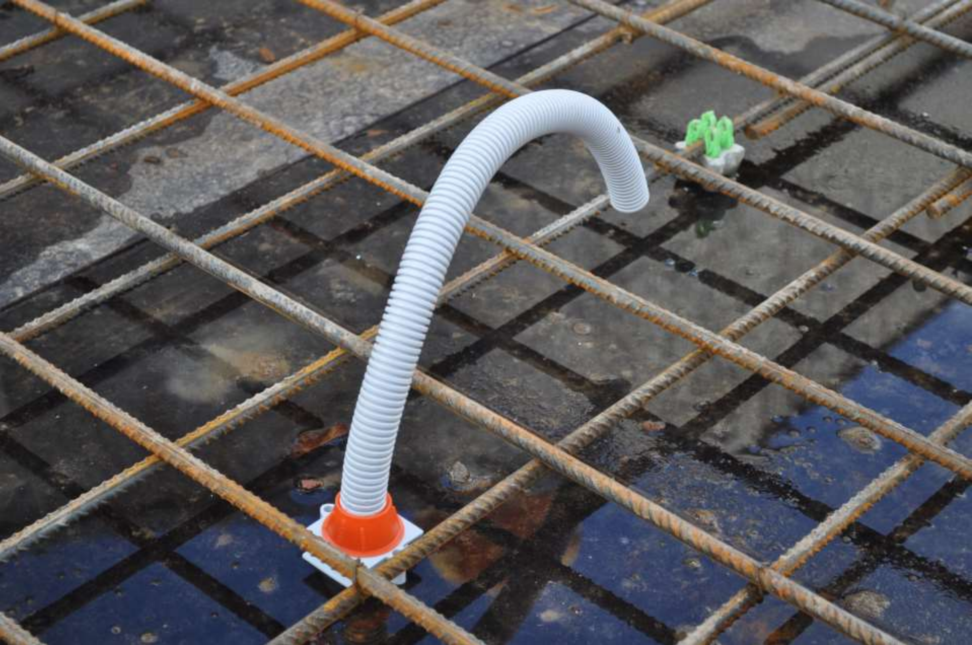
PRŮCHODKA ŽELEZOBETONOVOU DESKOU
