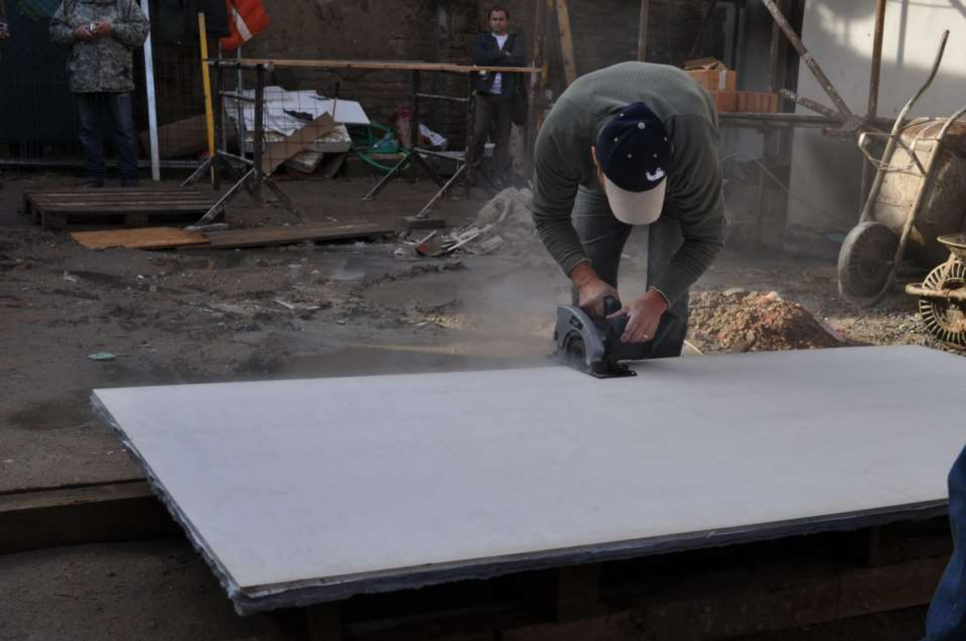
ŘEZÁNÍ MAGNEZITOVÉ DESKY S AEROGELOVOU IZOLACÍ
