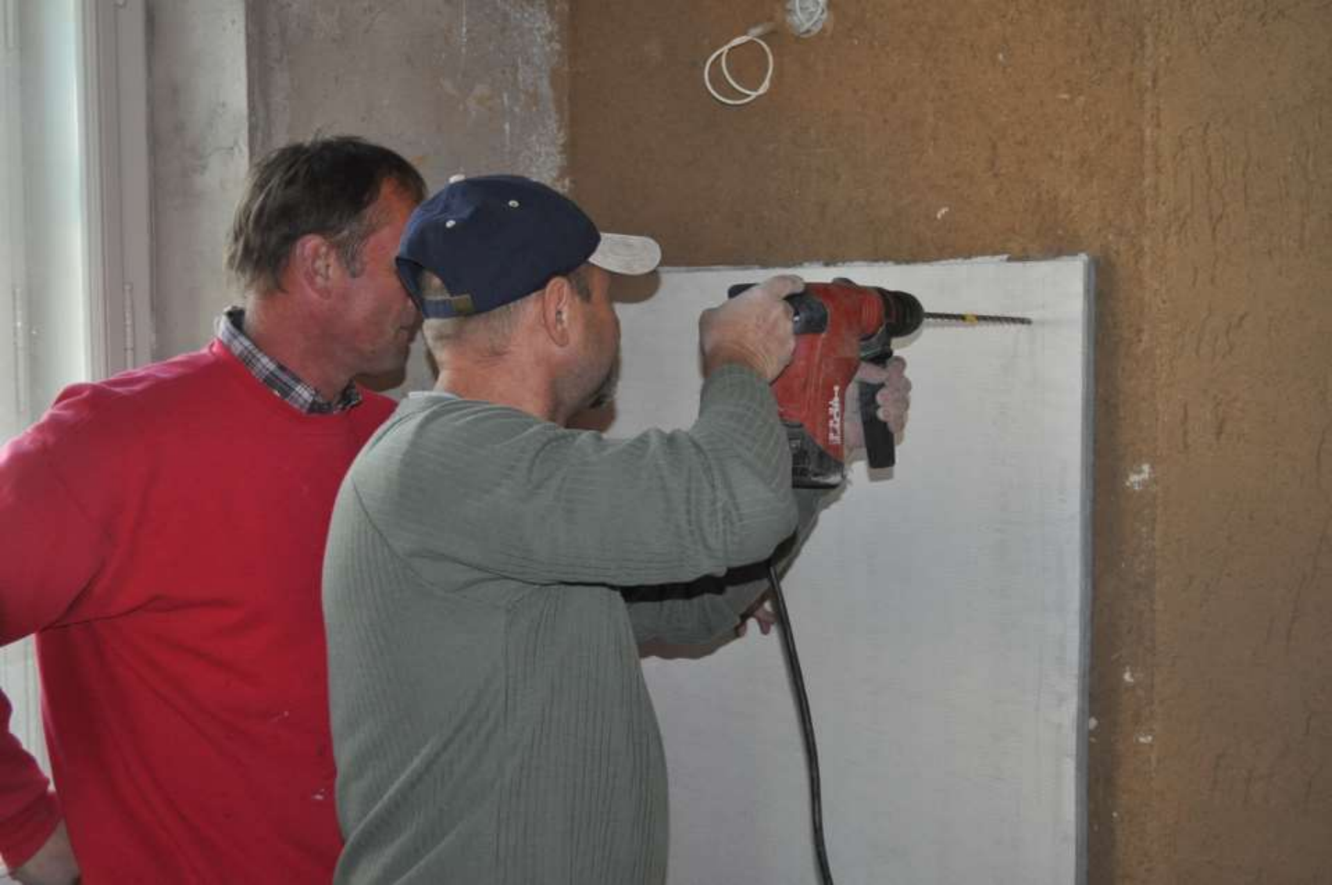
FIXACE MAGNEZITOVÉ DESKY S AEROGELOVOU IZOLACÍ
