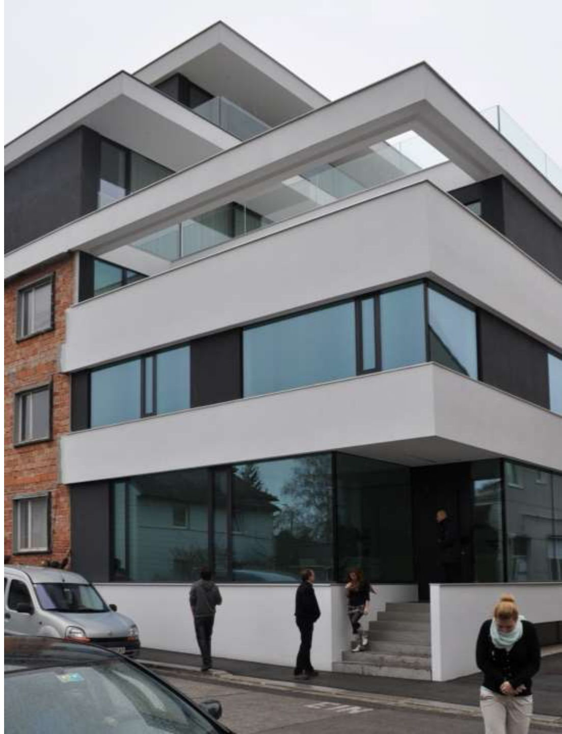
VAKUOVÁ TEPELNÁ IZOLACE NA FASÁDĚ OBYTNÉHO DOMU
