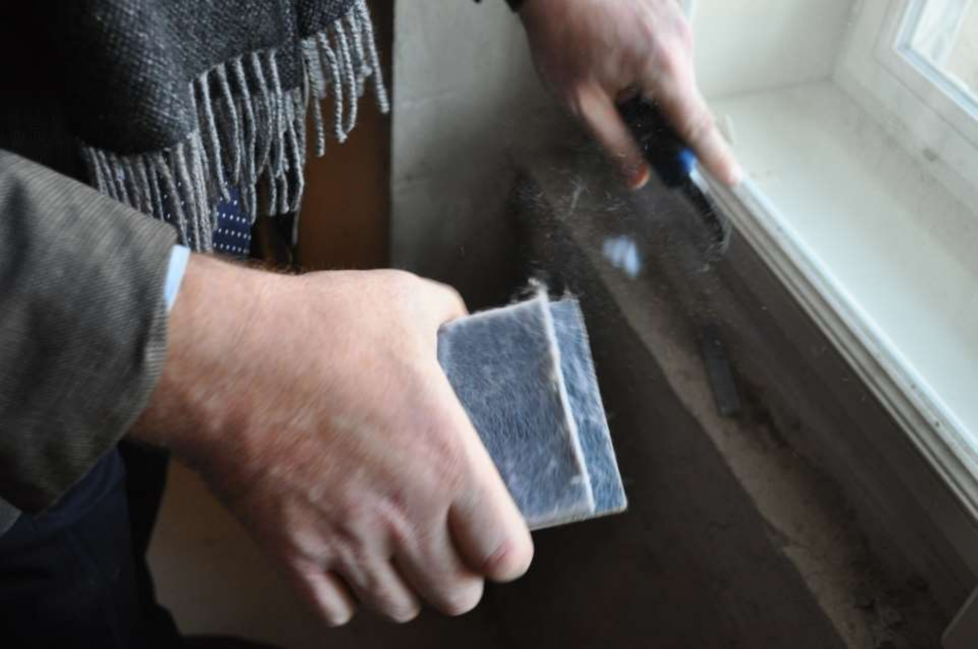
ÚPRAVA AEROGELOVÉ VRSTVY IZOLACE K VYTVOŘENÍ POLODRÁŽKY
