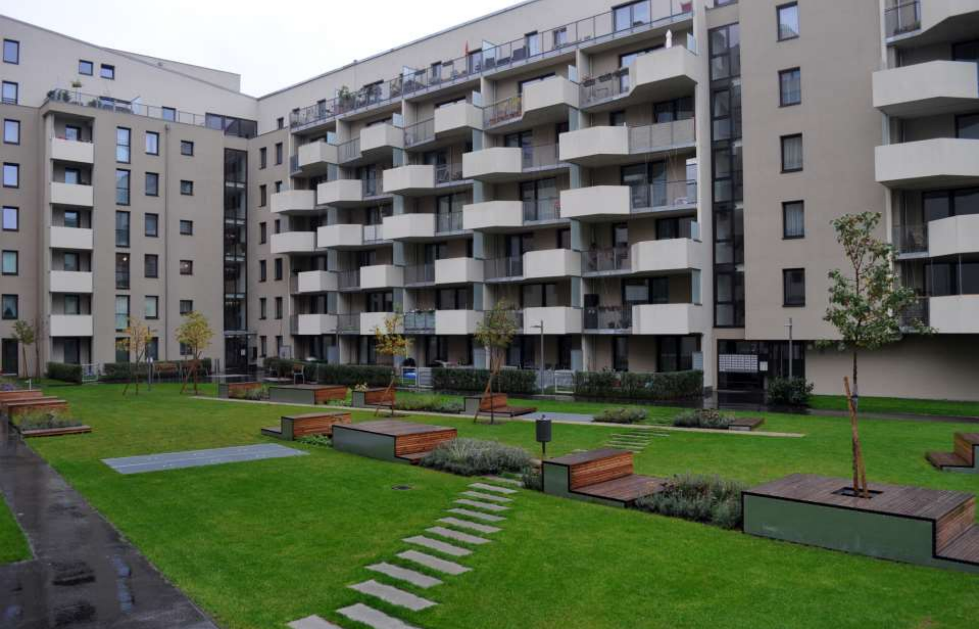
EUROGATE SÍDLIŠTĚ ENERGETICKY ÚSPORNÝCH DOMŮ VE VÍDNI ZE ŽELEZOBETONOVÉ NOSNÉ KONSTRUKCE
