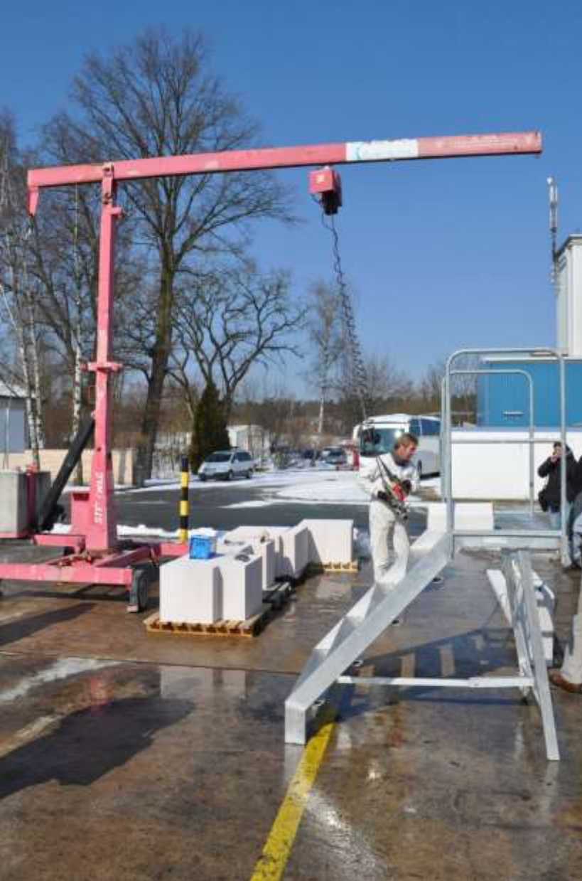
TECHNOLOGIE ZDĚNÍ Z VÁPENOPÍSKOVÝCH BLOKŮ
