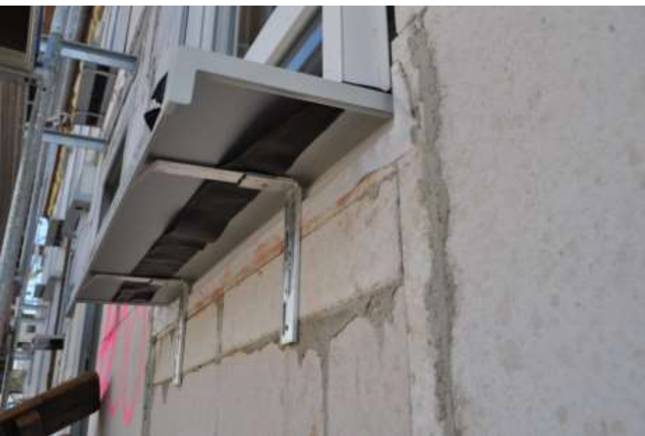
DETAILY S VP ZDIVEM 175 MM
