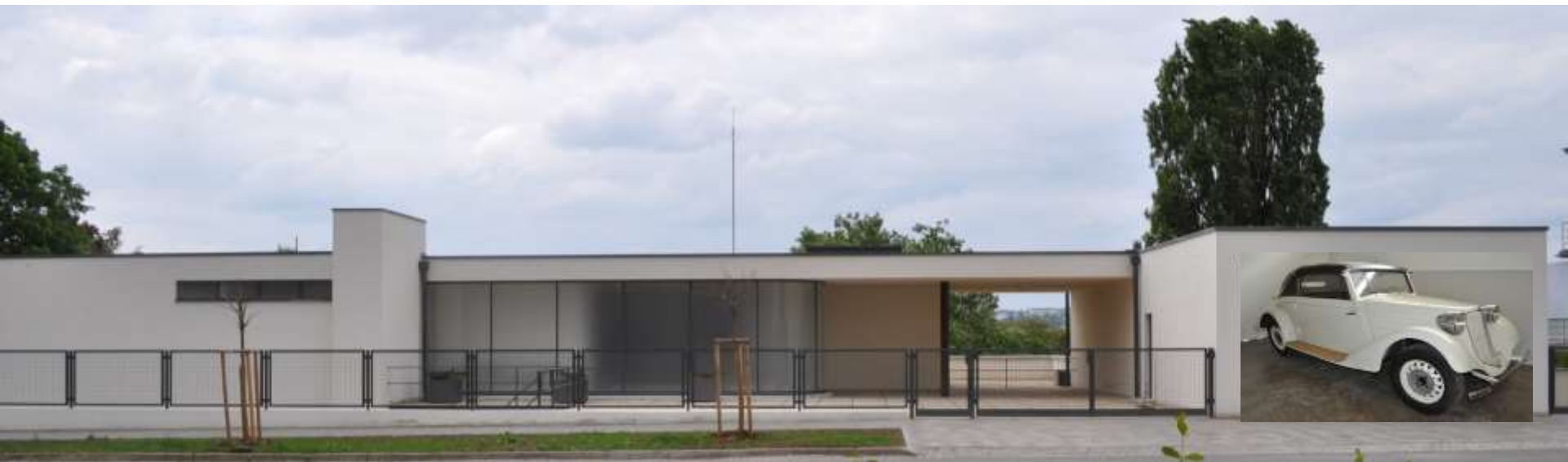
JIŽNÍ A SEVERNÍ FASÁDA VILY TUGENDHAT S GARÁŽÍ 12
