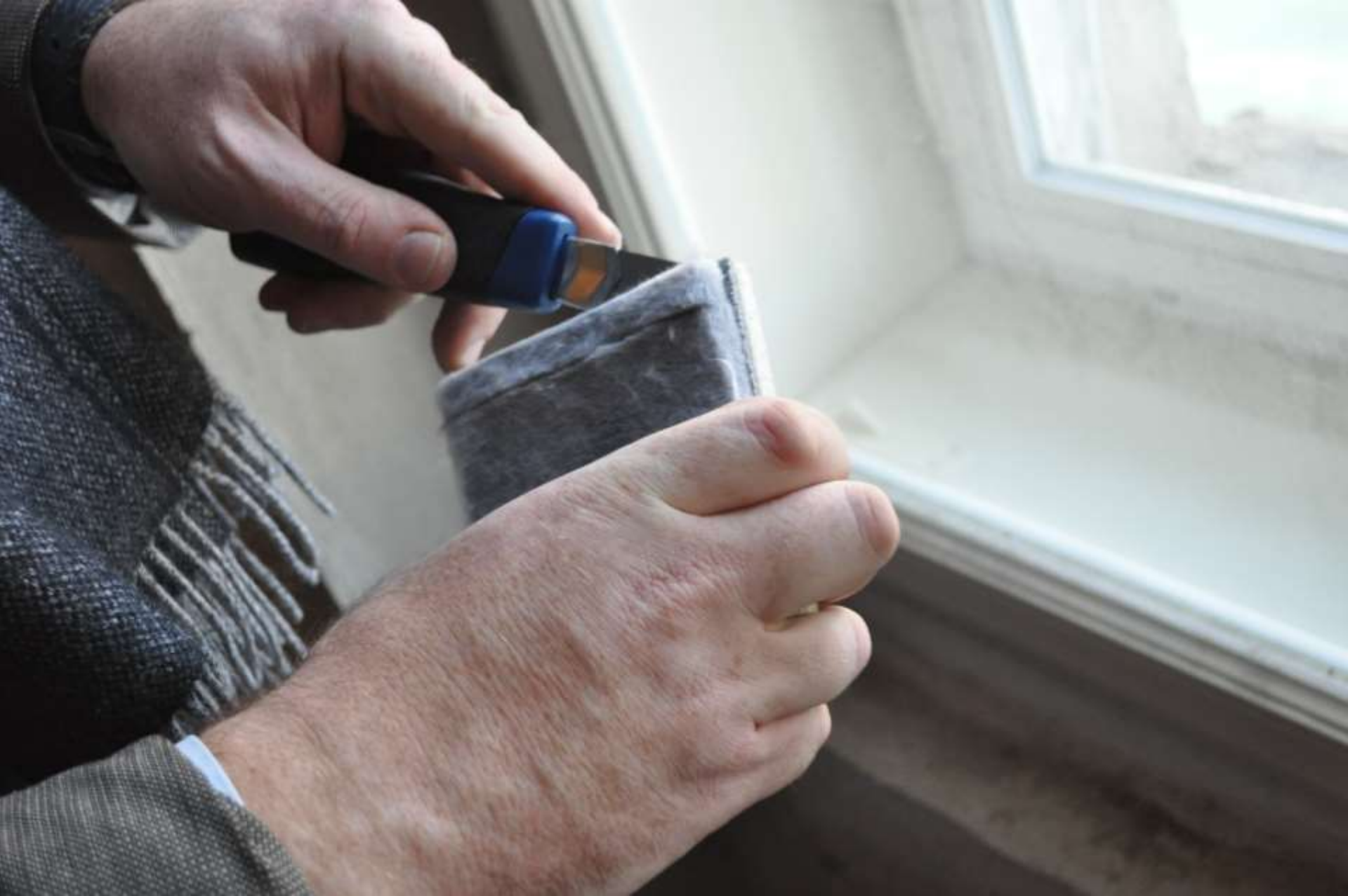
ÚPRAVA AEROGELOVÉ VRSTVY IZOLACE K VYTVOŘENÍ POLODRÁŽKY
