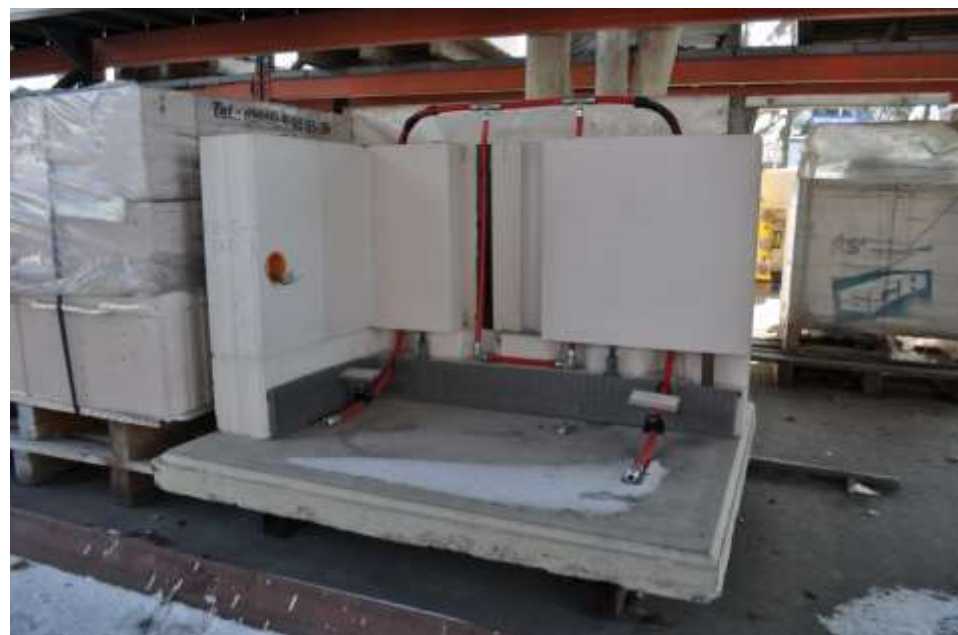
TECHNOLOGIE ZDĚNÍ Z VÁPENOPÍSKOVÝCH BLOKŮ A VEDENÍ POTRUBÍ UT
