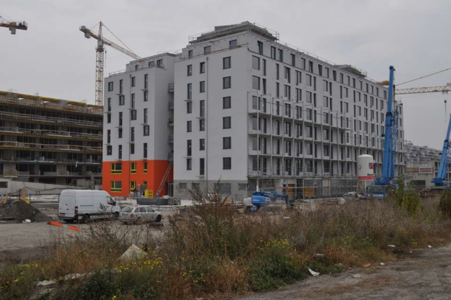
VÍDEŇ – VÝSTAVBA VELKÉHO PASIVNÍHO OBYTNÉHO DOMU S MATEŘSKOU ŠKOLOU Autor: Martin Treberspurg
