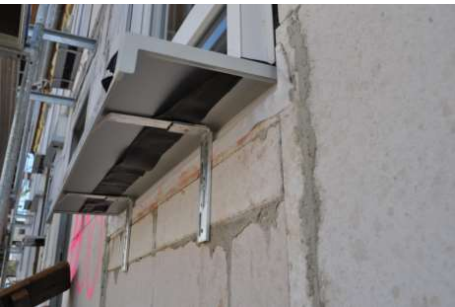
DETAILY S VÁPENOPÍSKOVÝM ZDIVEM TLUSTÝM 175 MM
