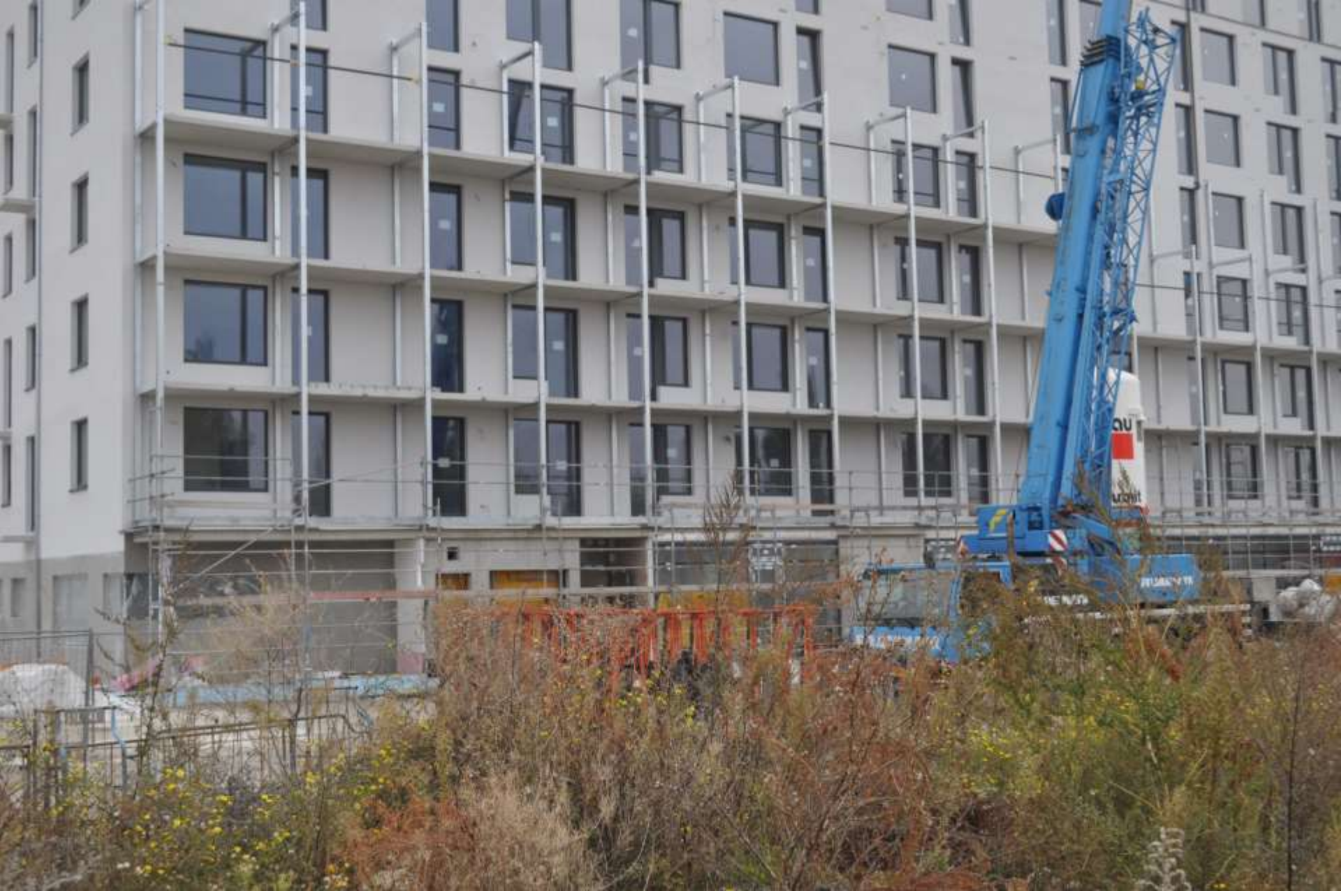
VÍDEŇ – VÝSTAVBA PASIVNÍHO OBYTNÉHO DOMU S PŘEDLOŽENÝMI LODŽIEMI Autor: Martin Treberspurg
