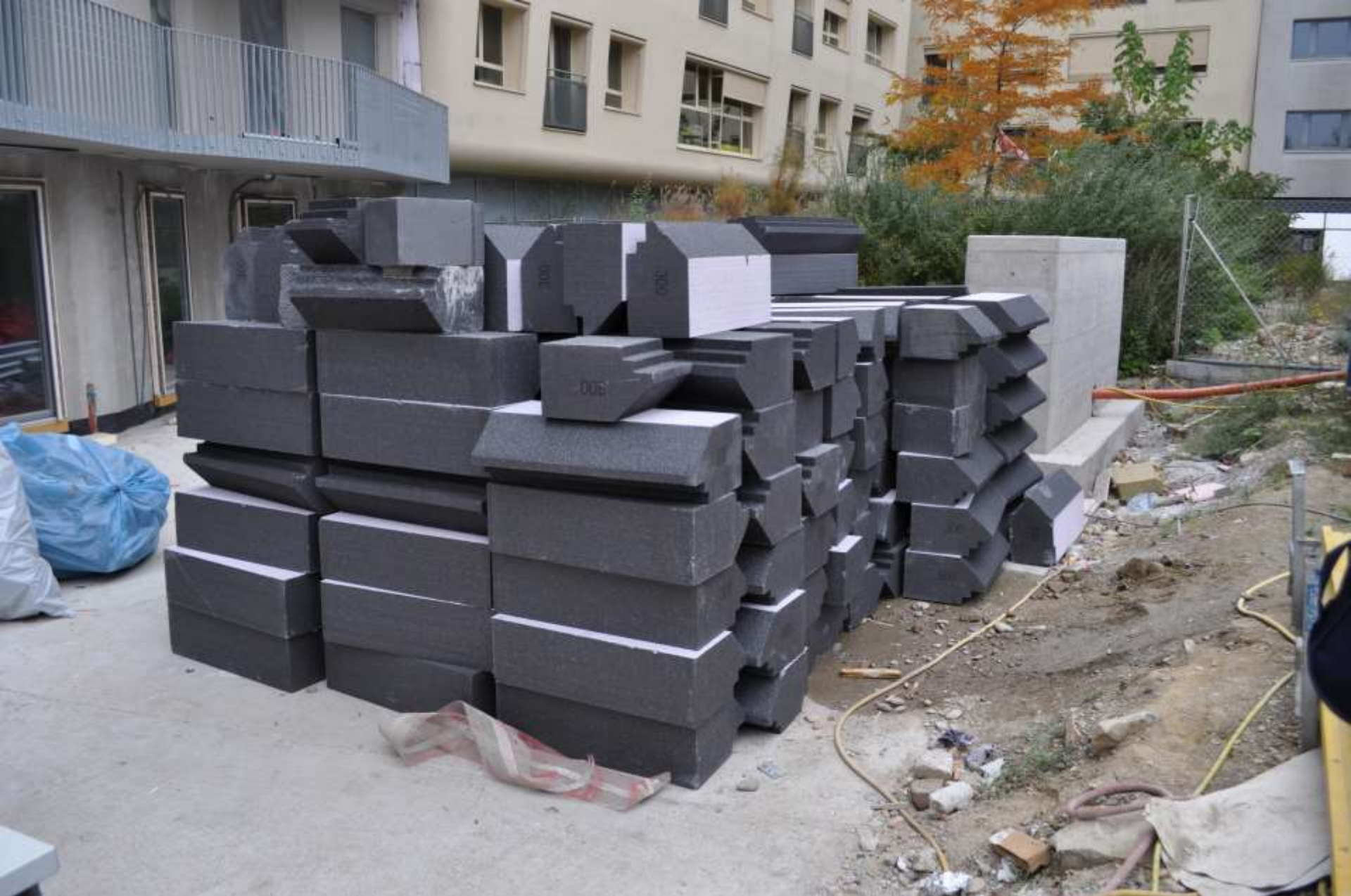
VÍDEŇ – TEPELNÁ IZOLACE PRO ZKOSENÁ OSTĚNÍ
