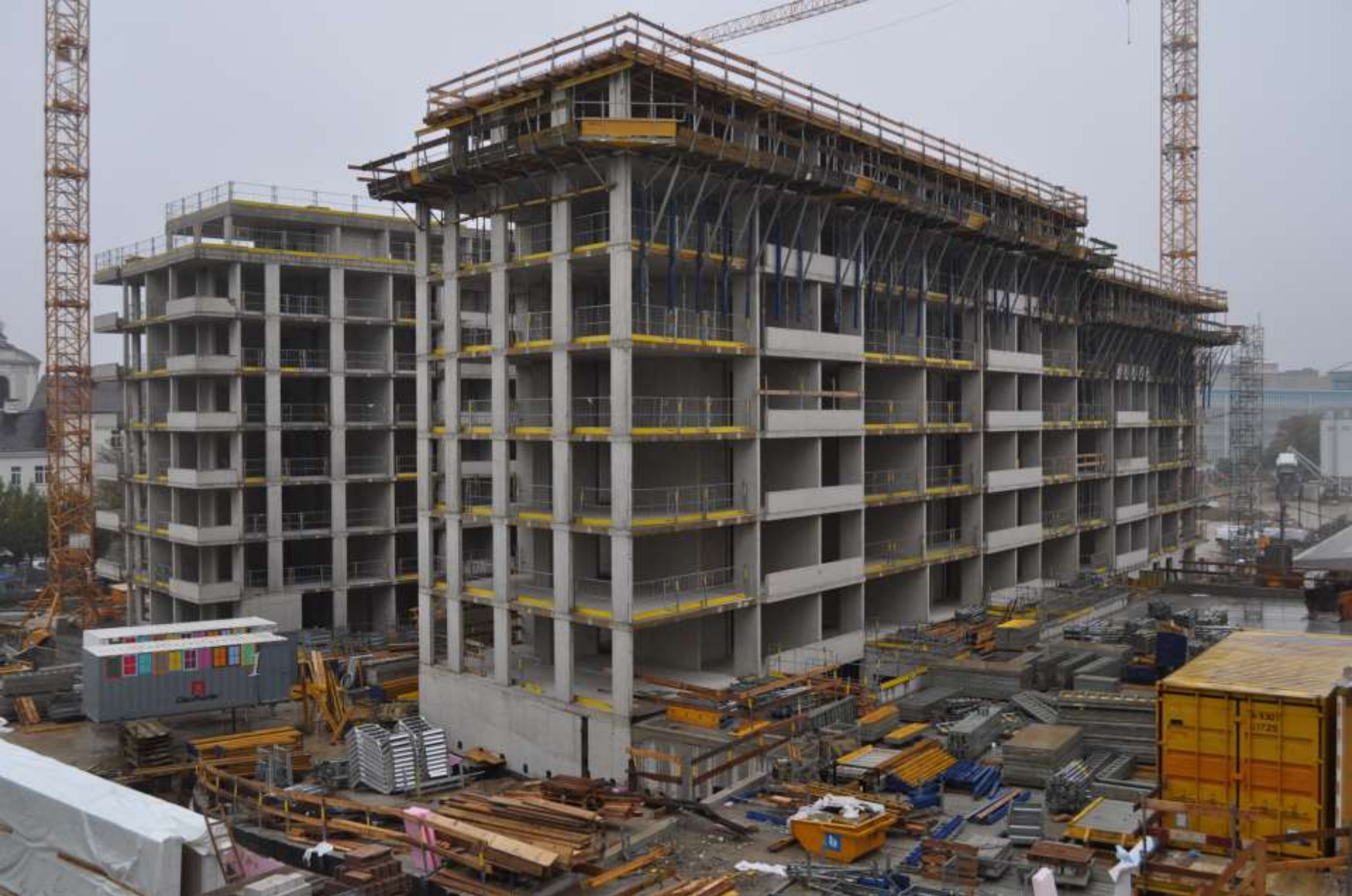
EUROGATE – SÍDLIŠTĚ ENERGETICKY ÚSPORNÝCH DOMŮ VE VÍDNI
