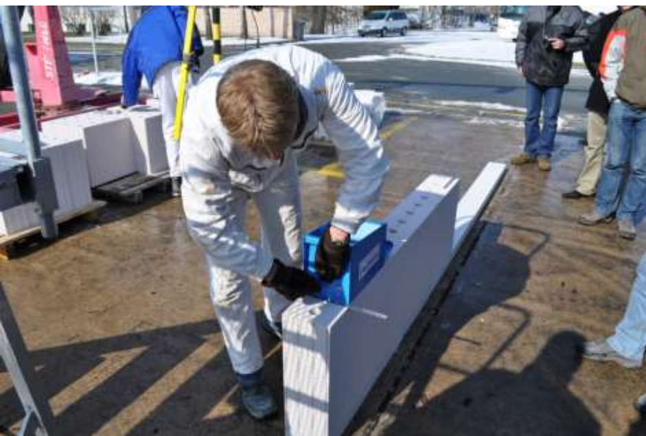
TECHNOLOGIE ZDĚNÍ Z VÁPENOPÍSKOVÝCH BLOKŮ A VEDENÍ POTRUBÍ UT
