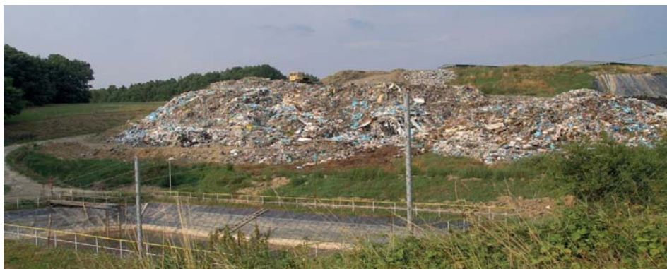
Špatně provozovaná skládka komunálních odpadů
