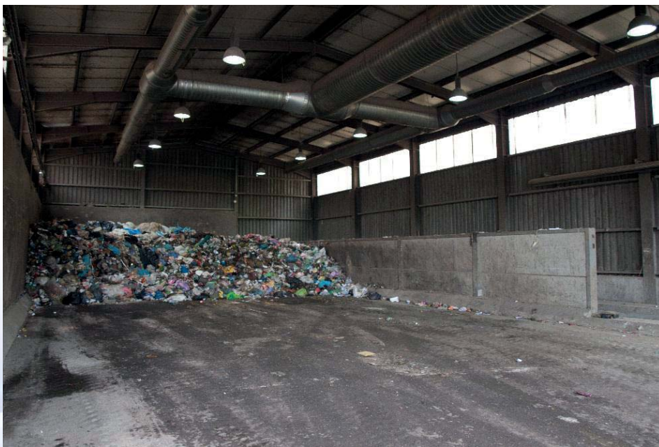
Překladiště směsného komunálního odpadu Vsetín
