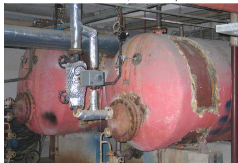
Nemocnice Uherské Hradiště, kotelna -- před realizací
