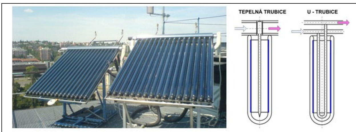
Obr. 17 Vakuové trubicové kolektory a rozdíl mezi kondenzačním (vlevo) a průtočným (vpravo) typem
