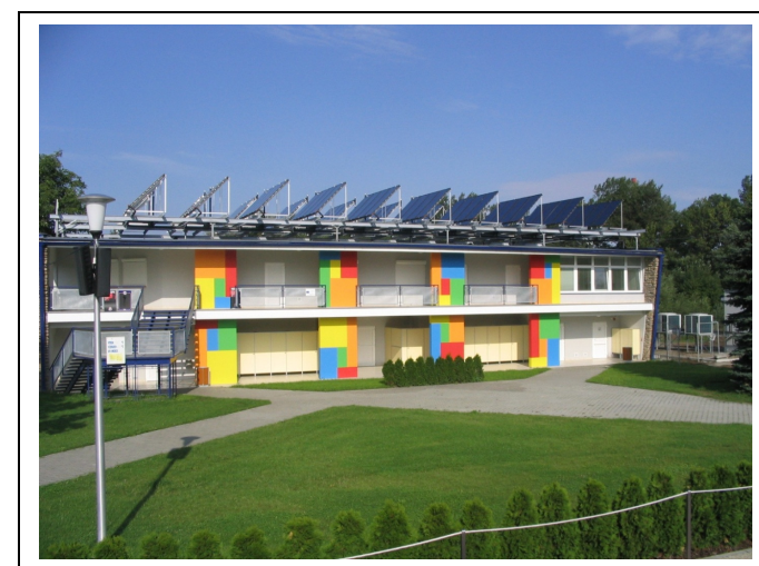
Obr. 69 Solární kolektory a tepelná čerpadla (v pozadí) na venkovním koupališti ve Valašském Meziříčí
