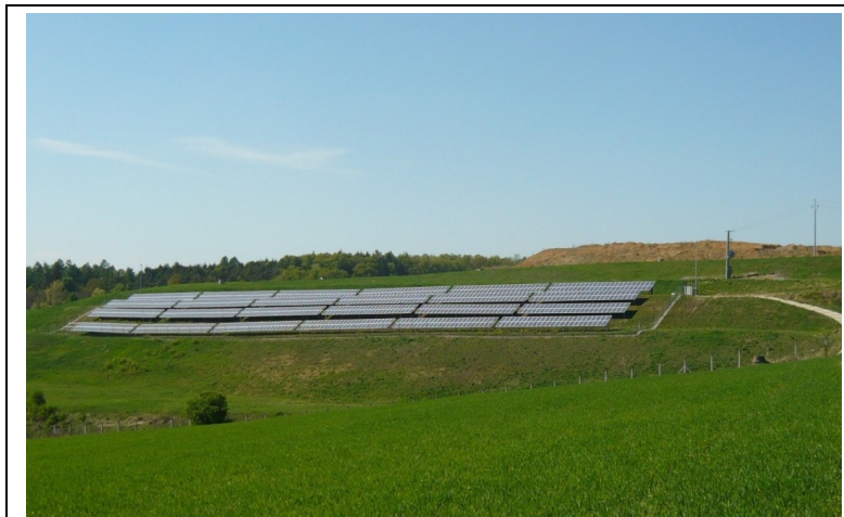
Obr. 64 FVE na rekultivované části skládky Suchý Důl u Zlína
