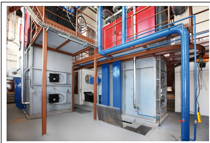
Obr. 67 Dva nové kotle na biomasu v Brumově-Bylnici
