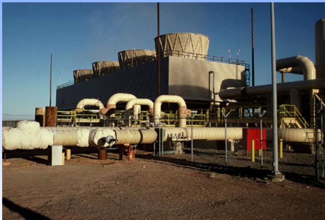
Geotermální elektrárna na mokrou páru v East Mesa v Kalifornii.
