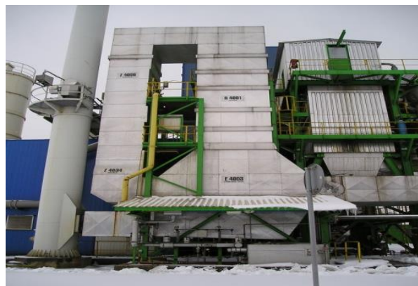
Obr. 100 Katalytický rozklad PCDD/F se současným odstraňováním NOx (Spovo Ostrava) (17)
