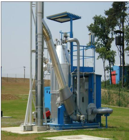
Obr. 83 Spalovací zařízení odplynů s rekuperačním výměníkem v kompaktním provedení (17)
