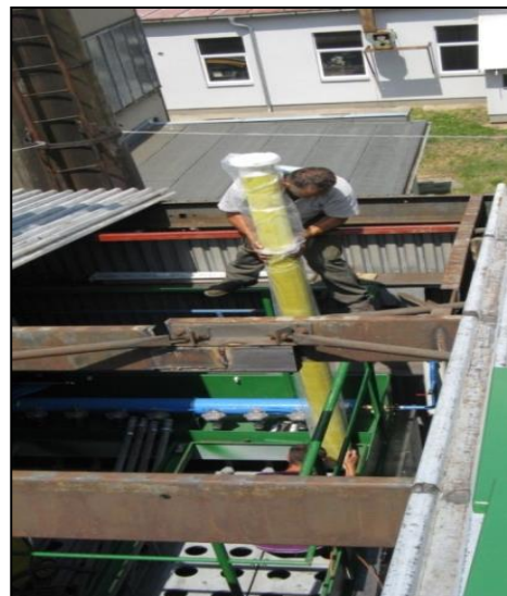
Obr. 115 Montáž keramických filtračních elementů do skříně filtru (Sporten, a.s.) (17)
