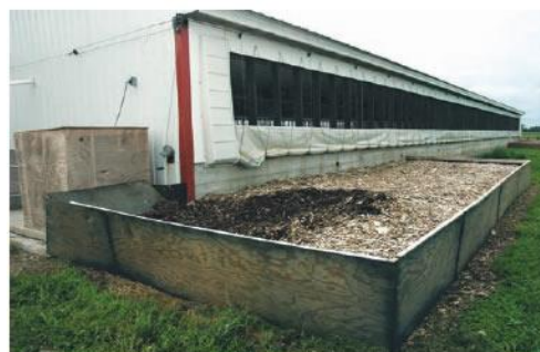
Obr. 91 Technické provedení bio filtru (11)
