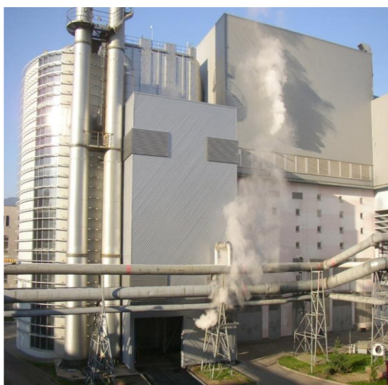
Obr. 107 Pohled na vnější opláštění skříně filtrů Termizo Liberec, a.s. (17)
