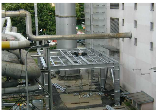
Obr. 105 Nosná konstrukce skříně Termizo Liberec, a.s. (17)
