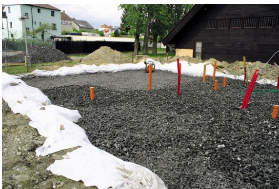
Založení na drti z pěnoskla
