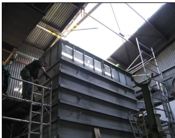
Obr. 116 Montáž skříně filtru na průmyslové spalovně odpadu (17)
