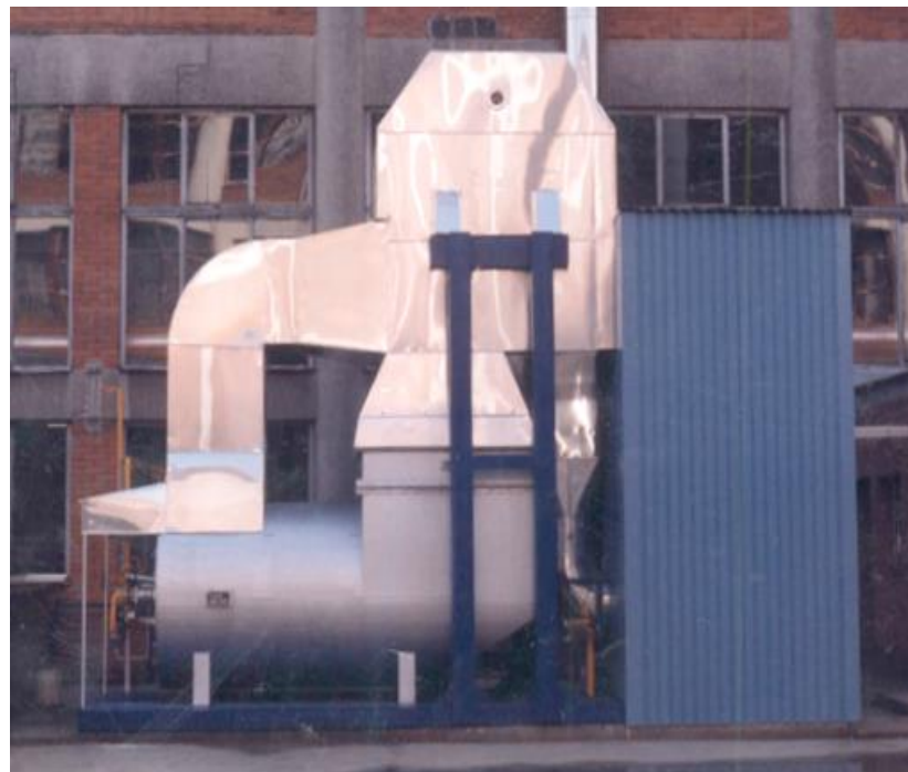
Příklad jednotky s rekuperací tepla
