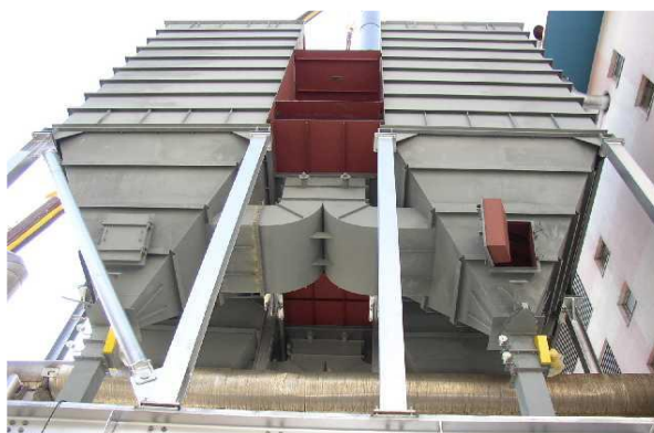
Obr. 106 Konstrukční provedení skříně filtrů Termizo Liberec, a.s. (17)
