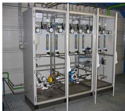
Obr. 63 Míchací a dávkovací zařízení (17)
