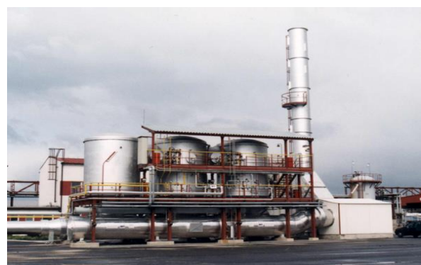
Obr. 84 Spalovací zařízení odplynů s regeneračními výměníky (15) (17)
