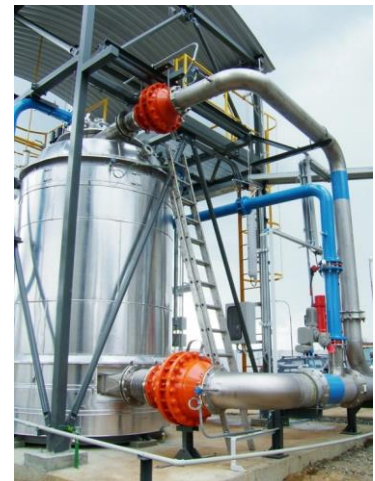
Obr. 83 Spalovací zařízení odplynů s rekuperačním výměníkem v kompaktním provedení (17)
