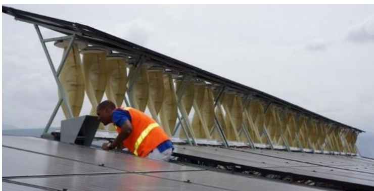
Obrázek 57: Kombinace VTE a FVE. Zdroj: Zdroj [27]
