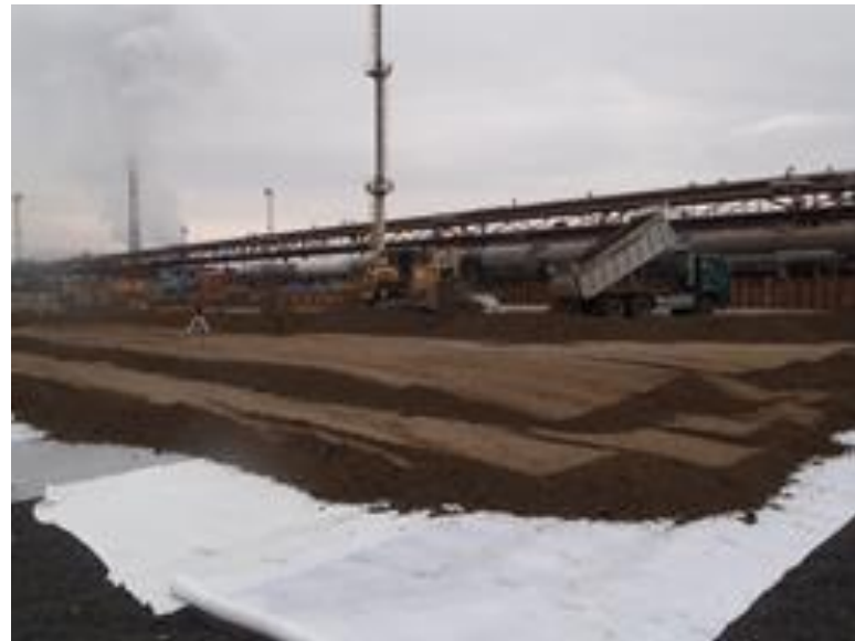
Dekontaminace půdy, Unipetrol, www.aldebaran.cz
