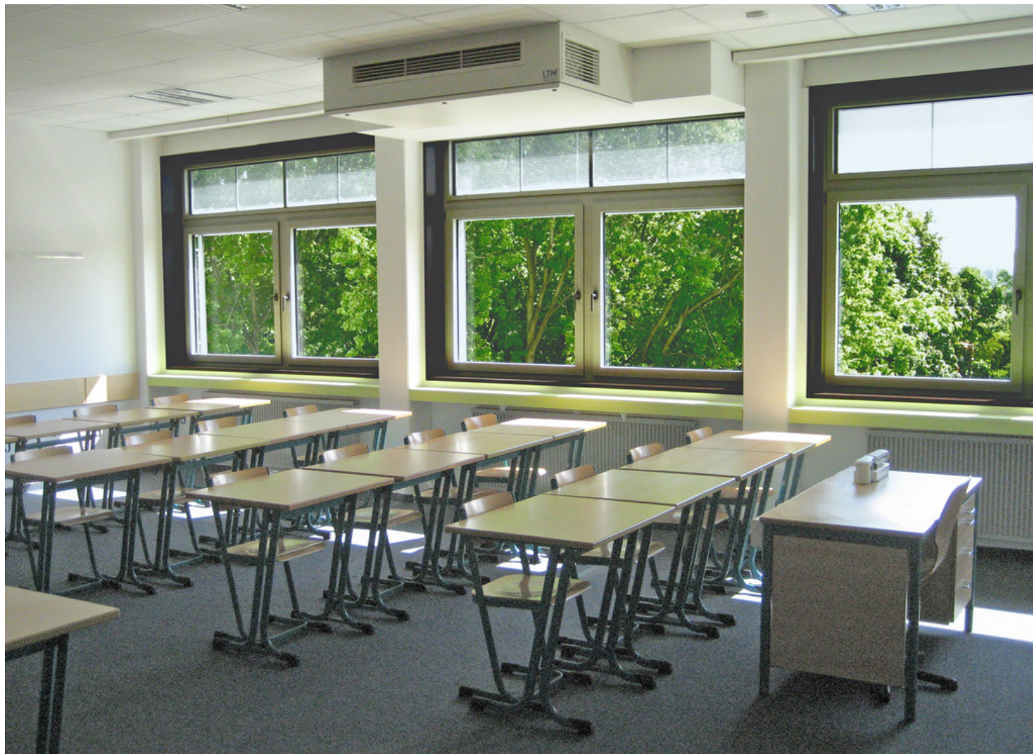
Obr. 14: Ilustrativní obrázek použití jednotky LTM dezent 800, zdroj: LTM
