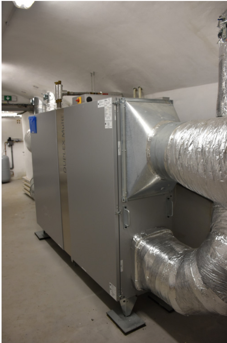
Obr. 5: VZT jednotka v suterénu – vertikální provedení, zdroj: EkoWATT
