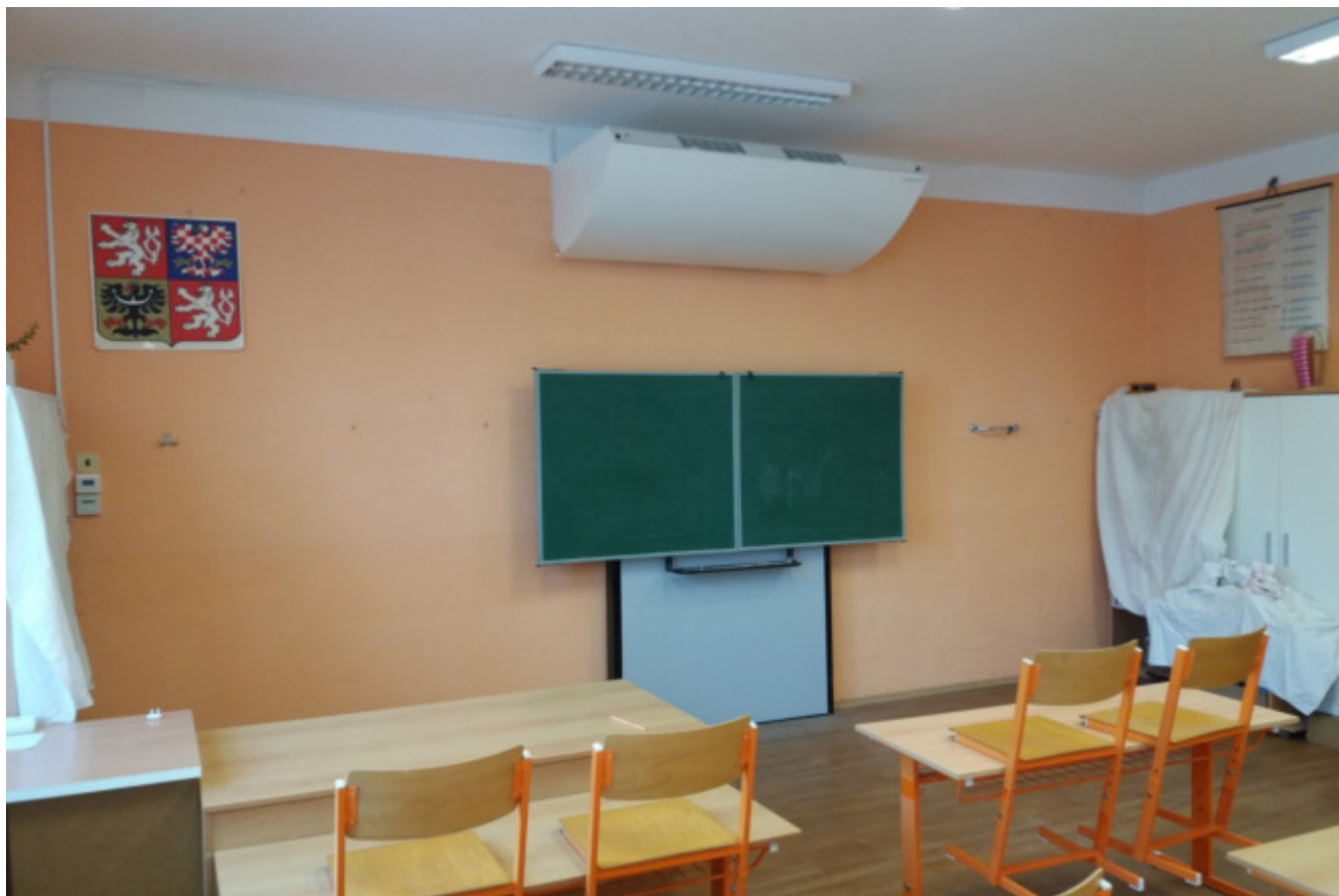
Distribuce vzduchu rekuperační jednotkou ve třídě ZŠ Janov , zdroj: Turbovex
