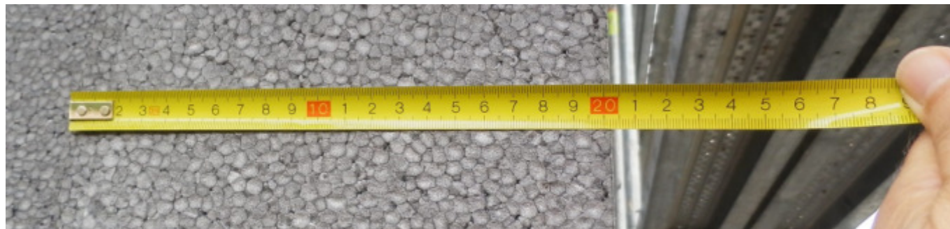
Obr. 11: Zateplení tělocvičny ZŠ Kralovice, zdroj: EkoWATT
