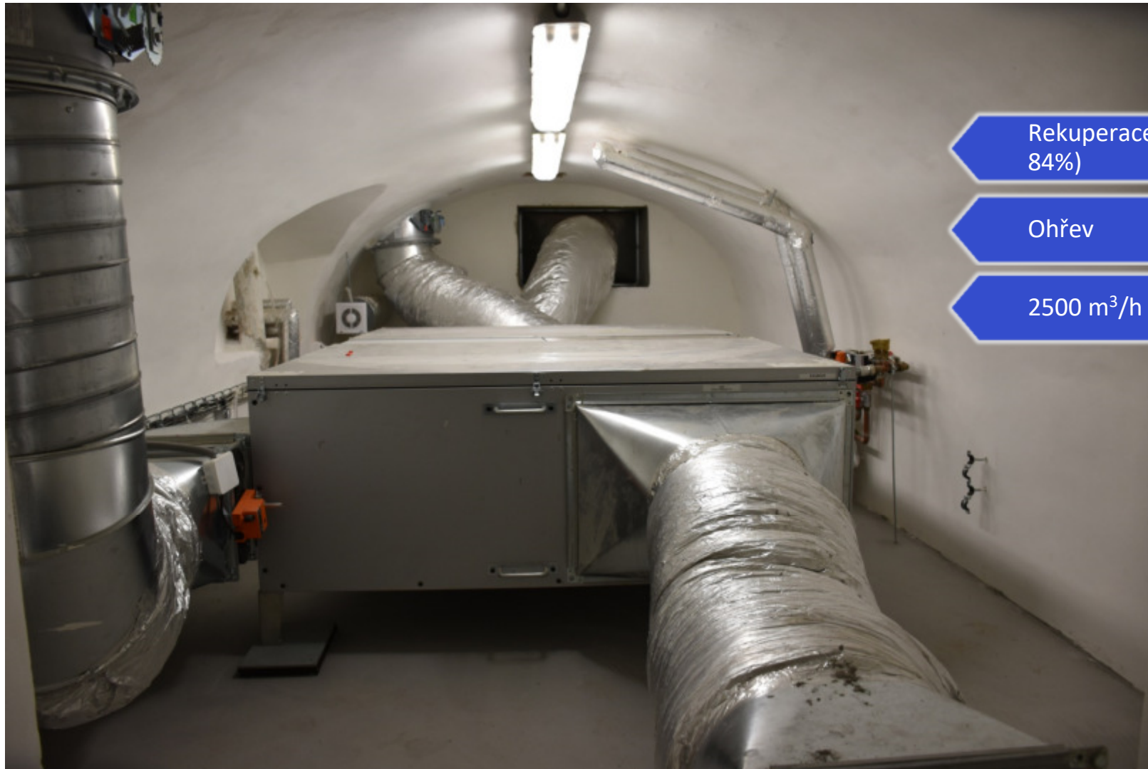
Obr. 4: VZT jednotka v suterénu – horizontální provedení, zdroj: EkoWATT
