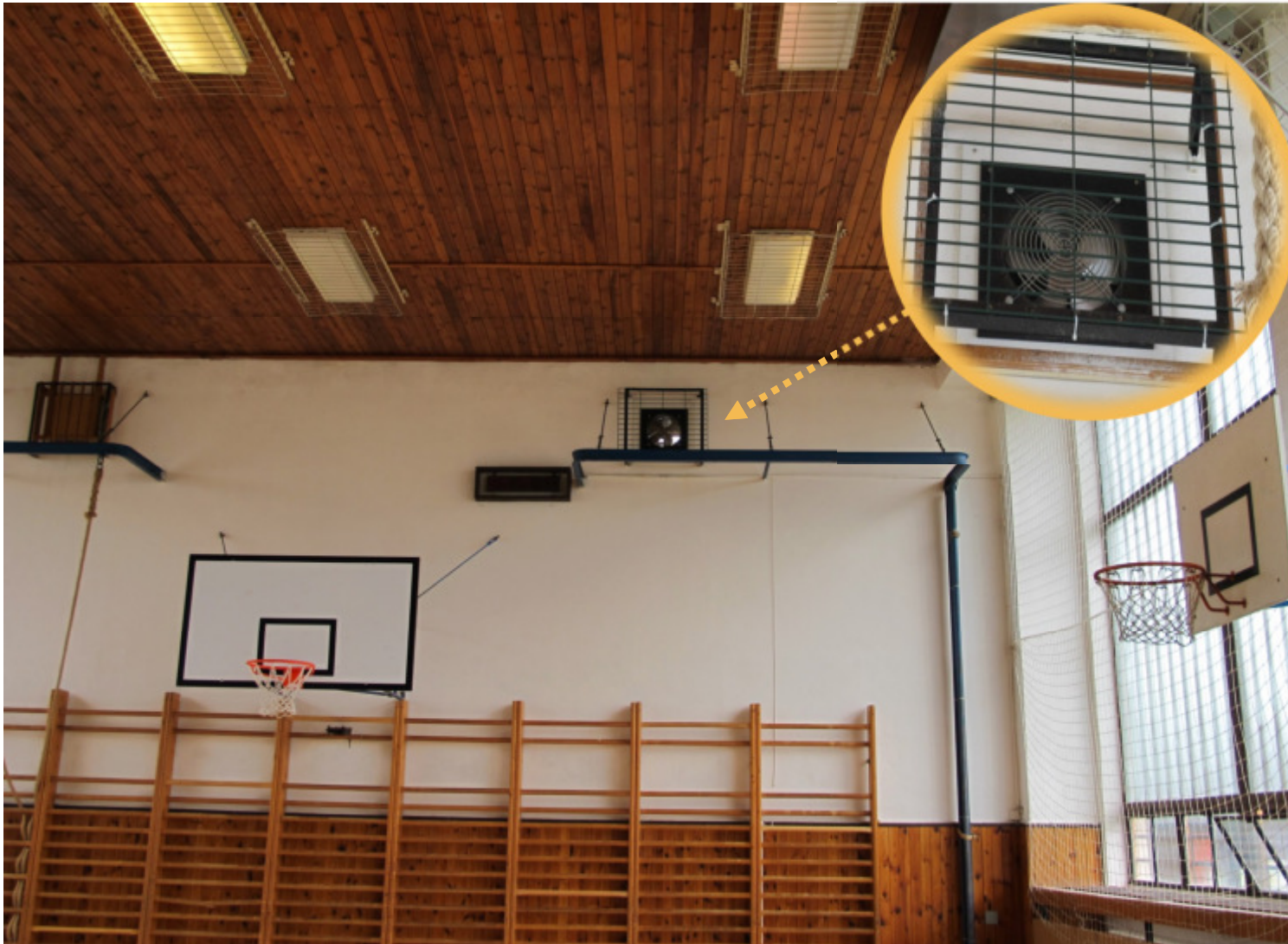
Obr. 7: Původní odtahové ventilátory tělocvičny ZŠ Kralovice, zdroj: EkoWATT
