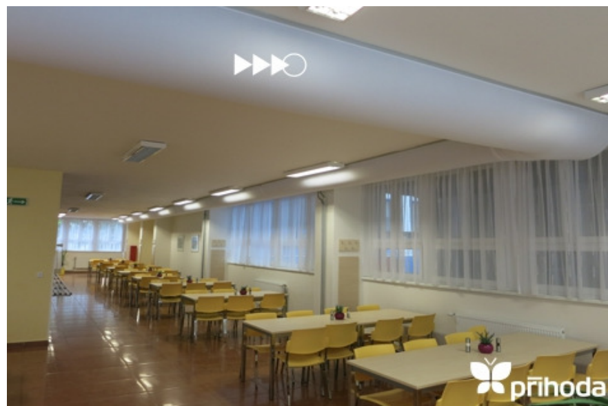
Příklady instalací textilního VZT potrubí
