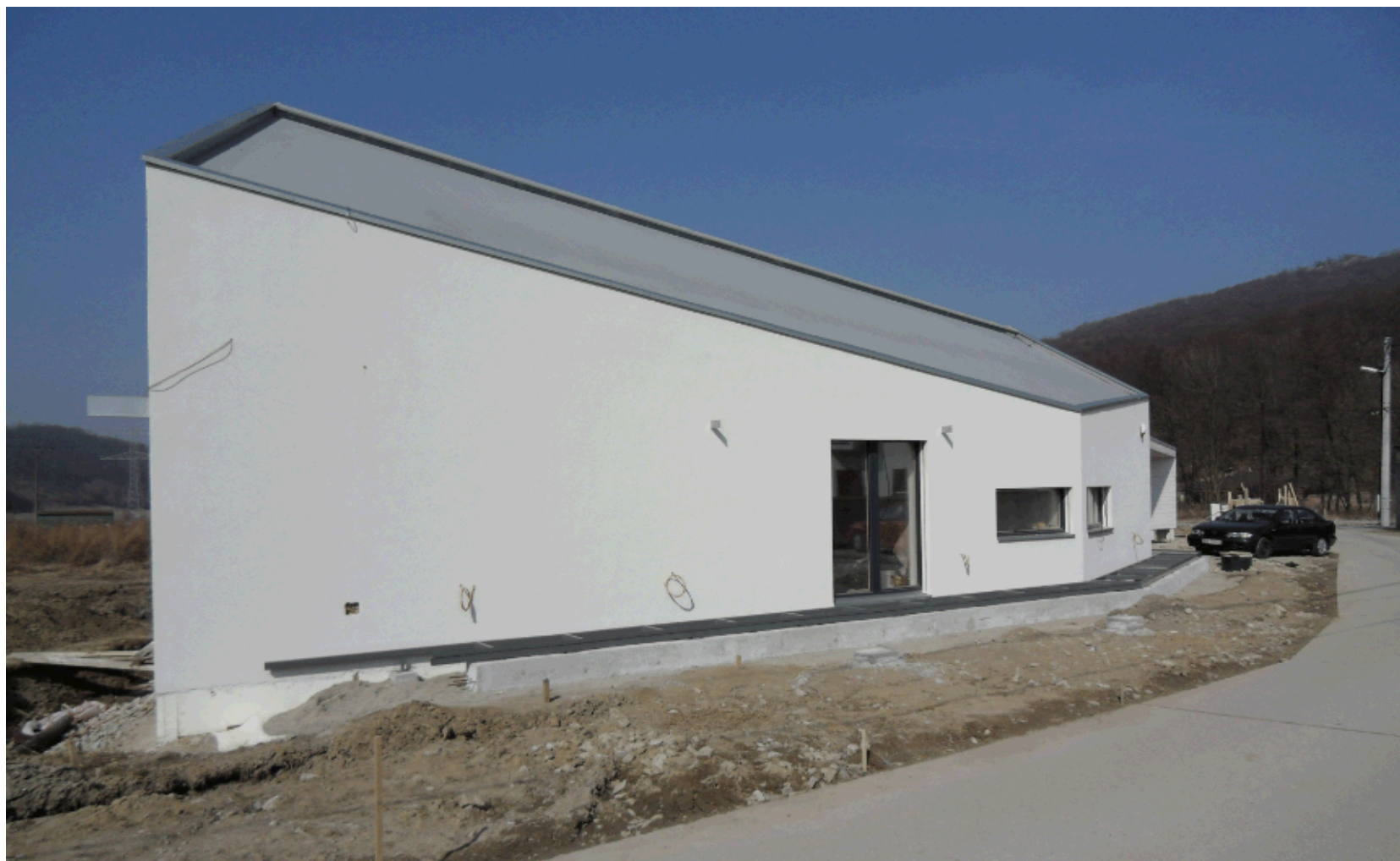
POHLED Z JIHOVÝCHODU – IZOLACE POD ZELENOU STŘECHOU
