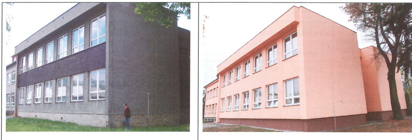
Ukázka modernizace budovy projektu č. 2 před a po zateplení
