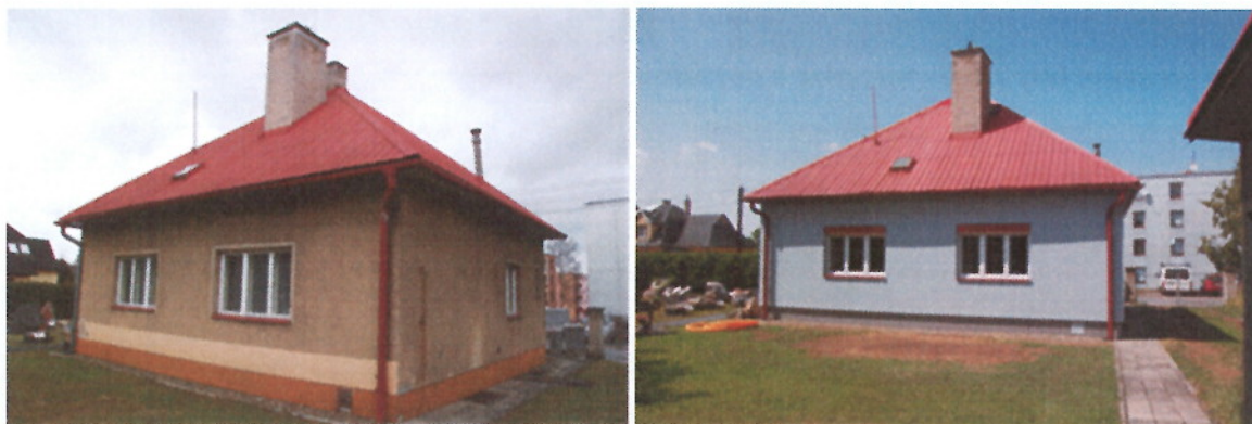
Hvězdárna Valašské Meziříčí, p. o. - energeticky úsporná opatření na provozně-technickém objektu – foto před a po realizaci
